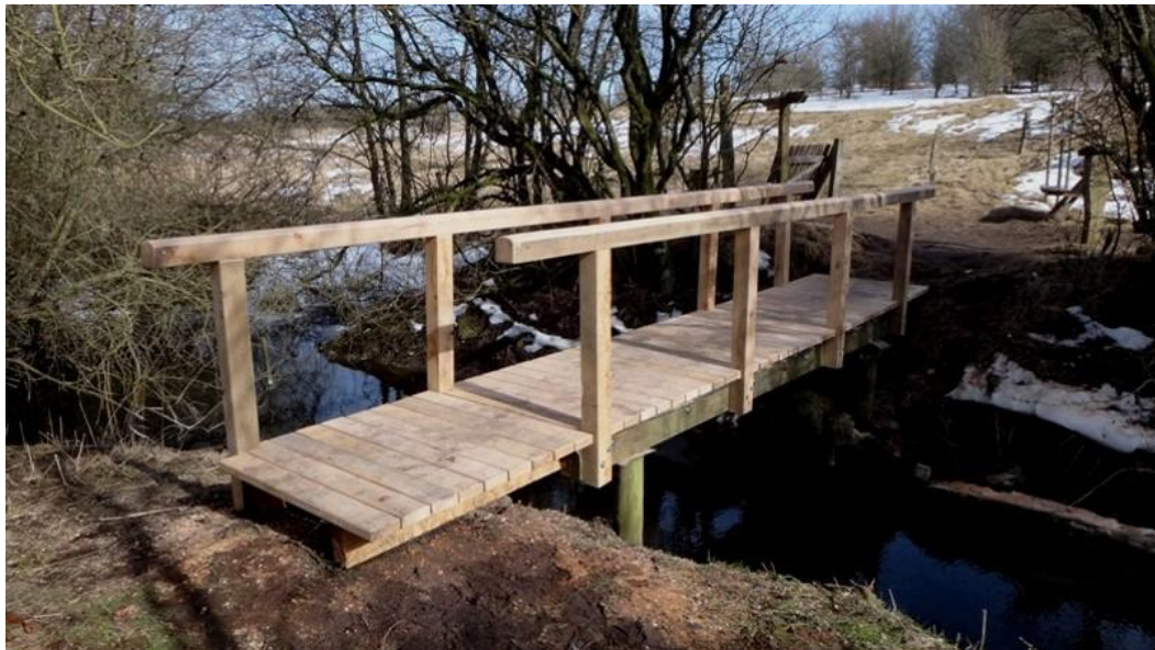
Abb.: Neubau der Hühholz-Brücke über die Kielstau
