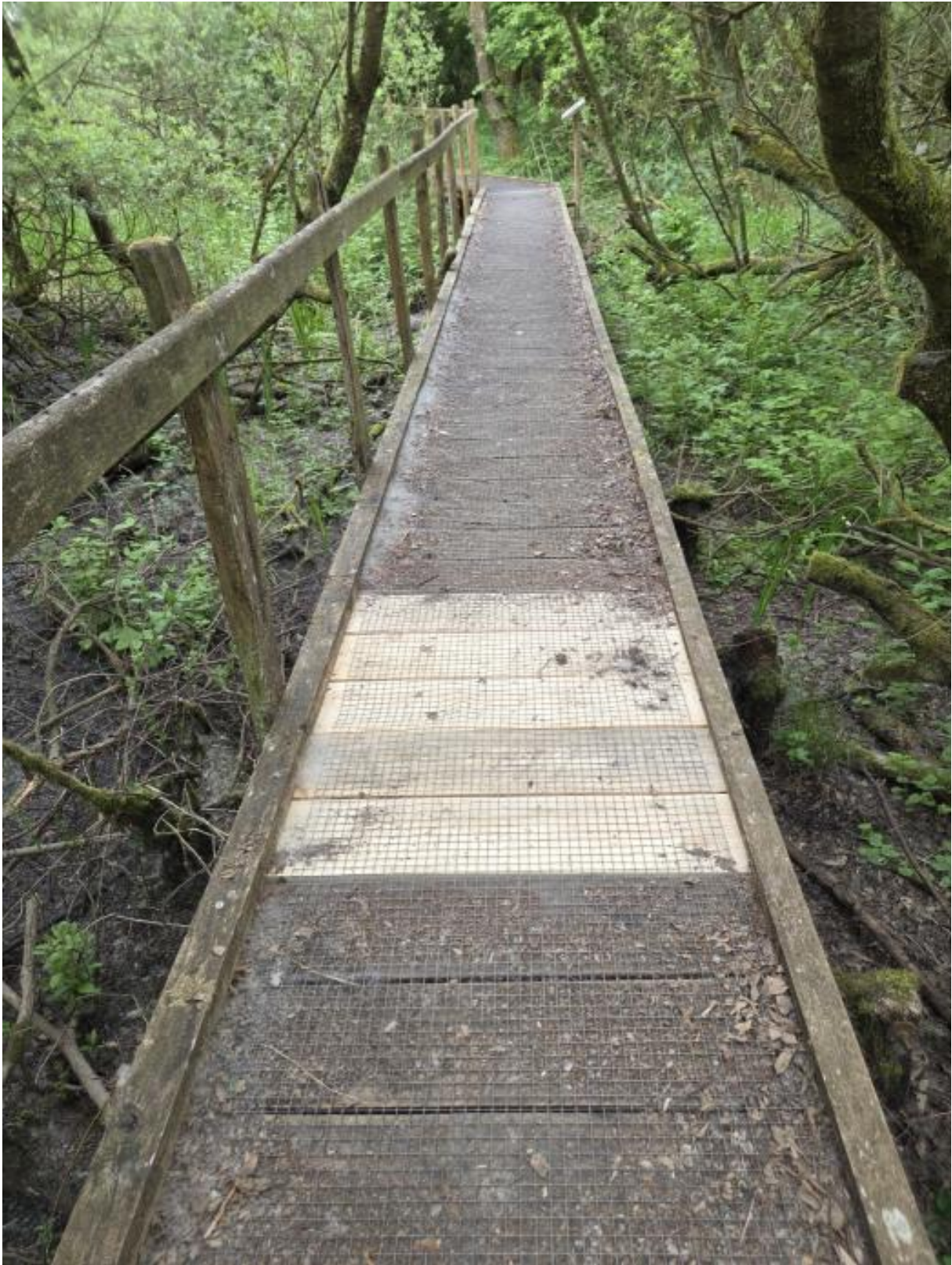
Foto: Bohlenwegreparaturen (Foto: Lutz Mallach)
